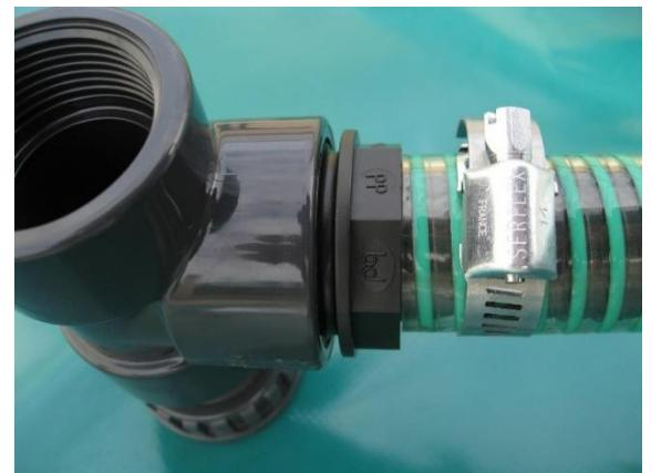
Etape 5 : montage du tuyau souple sur le collecteur à l'aide du collier de serrage.
